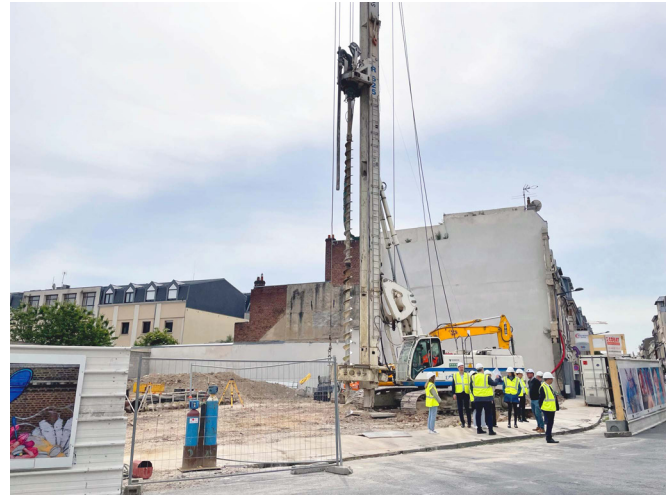
Visite du chantier rue Raspail, à Saint-Quentin, en présence de Nicolas Fricoteaux, Freddy Grzeziczak, Jean-Denis Mège et Frédérique Macarez.
