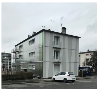
Vues pendant travaux
