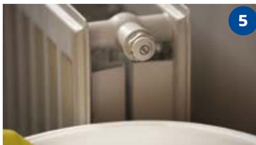
**Laisser l'air sortir (sifflement) jusqu'à ce que l'eau s'écoule en filet continu. Laisser couler l'eau 5 secondes puis refermer le purgeur.**
