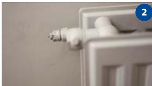
**Vérifier que le petit clapet ne soit pas resté enfoncé.** Si besoin, utiliser un dégrissant pour le débloquent.
