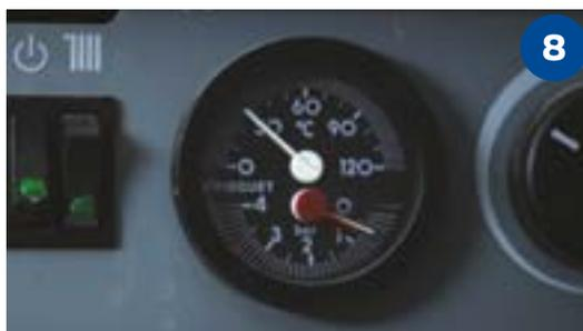
**Contrôler le niveau de pression sur la chaudière.**
