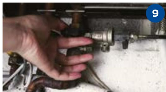
**Si le niveau de pression est insuffisant, utiliser la vanne de remplissage (cf notice de la chaudière) pour rajouter de l'eau dans le circuit.**
