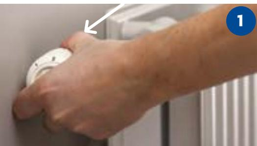
**Mémoriser la position de la tête du robinet et la retirer** (la plupart du temps, il suffit de tirer vers soi).
