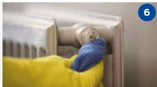
**Passer un coup de chiffon sur le purgeur. Vérifier au bout de 30 minutes qu'il n'y ait pas de goutte (qui indiquerait un purgeur mal refermé).**
