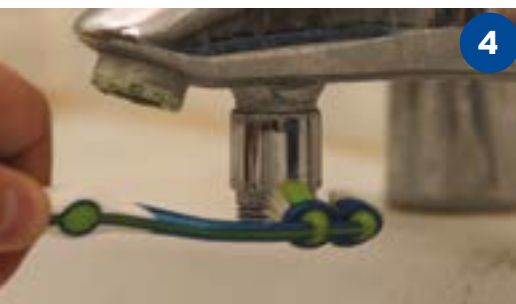
Nettoyer les résidus de tartre sur le robinet et le pommeau en frottant avec une brosse à dents et du vinaigre blanc.
