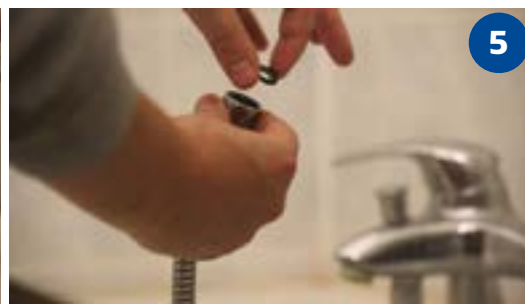
Veiller à bien installer les 2 joints dans chacune des parties du nouveau flexible.
