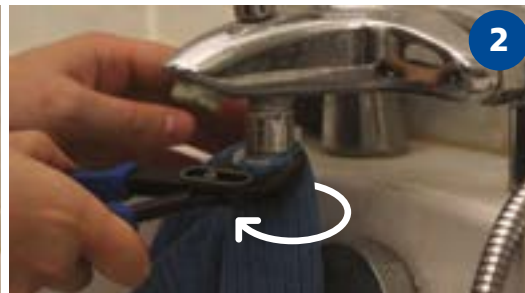
En cas de résistance, utiliser une pince et un chiffon puis finir de dévisser à la main.
