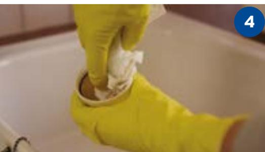
4 Retirer le bouchon et nettoyer le siphon (parties fixe et dévissée).
