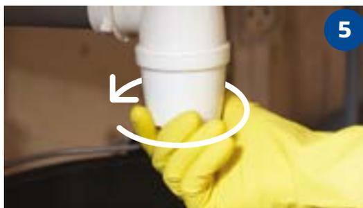
5 Positionner le joint sur la partie dévissée et revisser celle-ci sur la partie fixe du siphon.
