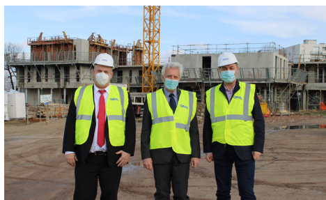
VISITE DU CHANTIER FOYER DE JEUNES TRAVAILLEURS 02000 LAON
