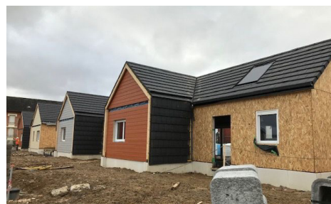
42 LOGEMENTS POUR SENIORS EN COURS DE CONSTRUCTION 02300 CHAUNY
