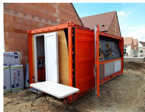
Plateforme de formation FIT
